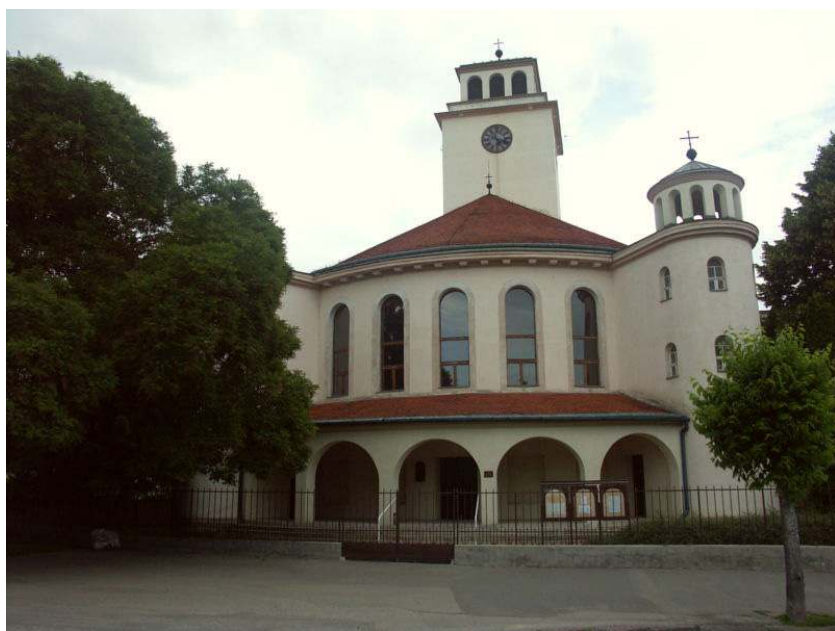
Kostol ECAV v Trnave postavený vo funkcionalistickom štýle v roku 1924 českým architektom Josefom Marekom
